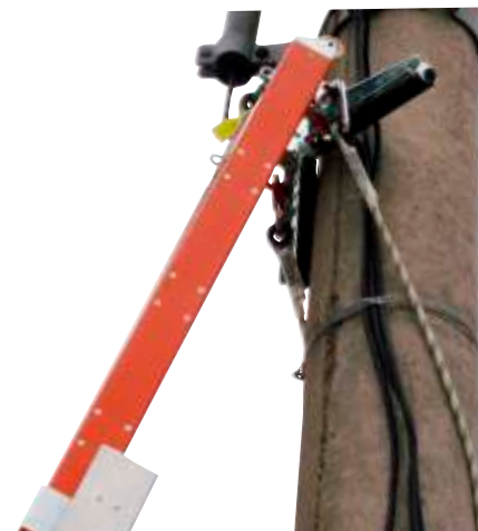
Dispozitiv compensator de înălțime (picior pentru denivelări)
