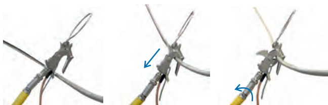
APLICARE CLEMĂ - OPERATOR POZIȚIONAT SUB CONDUCTOR
